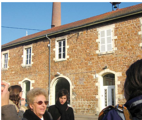
Atelier de terrain au quartier Déchelette d'Amplepuis Photographie Annie Dhénin
