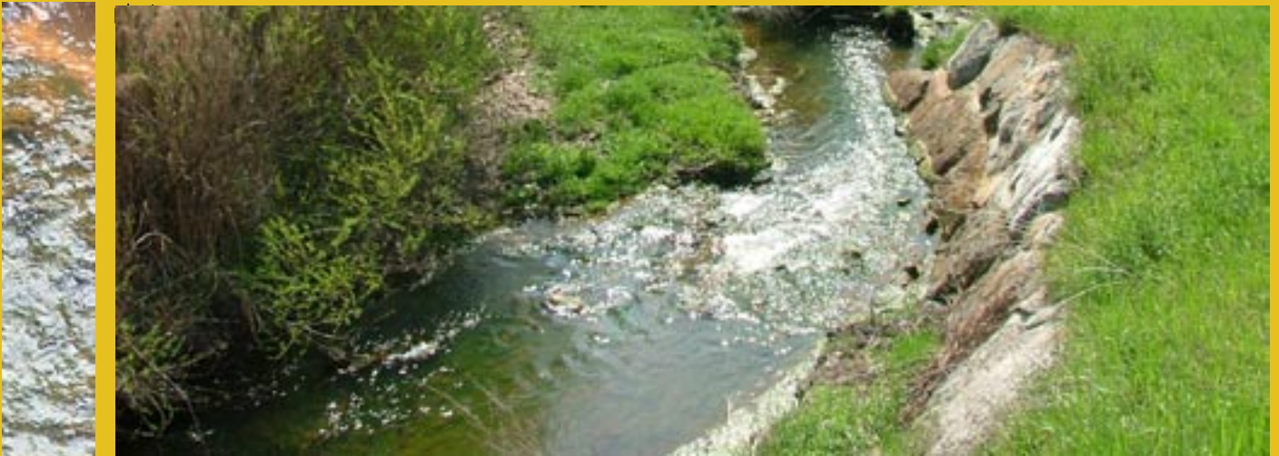
L'Ondaine en aval du Puits du Marais au Chambon Feugerolles : aménagement de la rivière et enrochement pour éviter une forte érosion tout en laissant une zone inondable.
