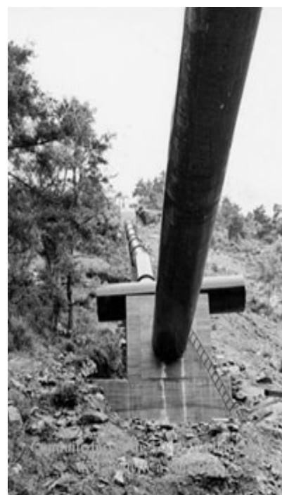
Conduite forcée du Lignon
