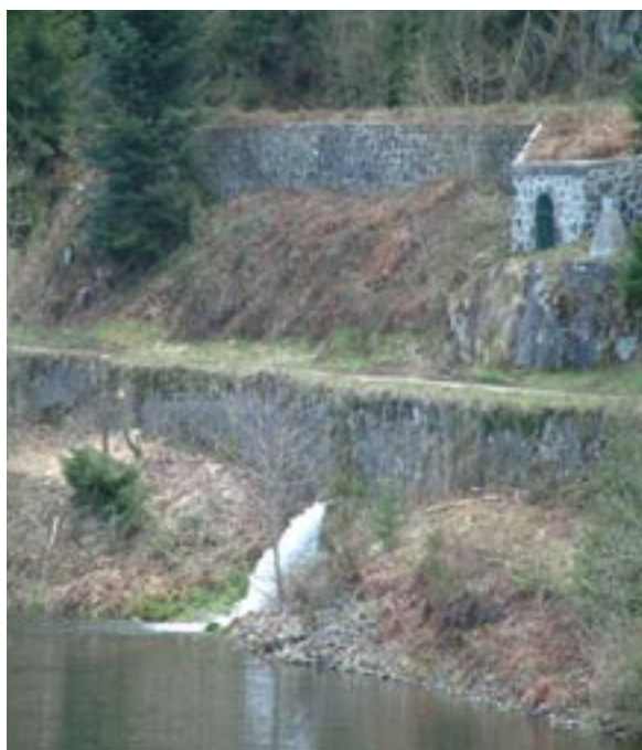
Arrivée du trop plein des sources dans le barrage du Pas du Riot.
