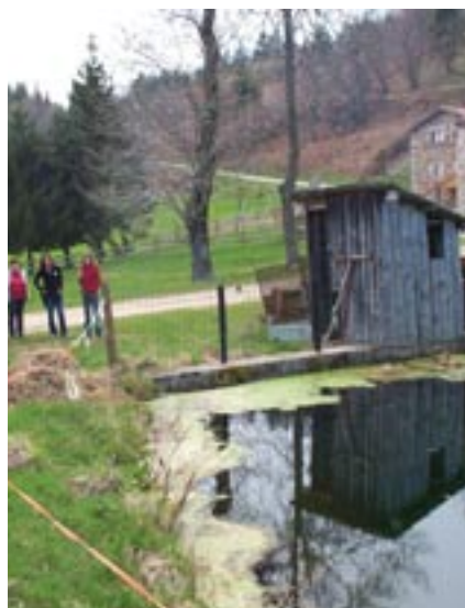
Parcours des eaux usées d'une partie de l'exploitation jusqu'aux lagunes d'épuration précédents les fossés drainants.
